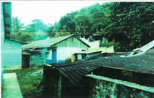
Foto 1: Vista panorámica de la cocina, el baño y el salón de laboratorio o bodega, que será remodelado su techo, puertas y ventanas
