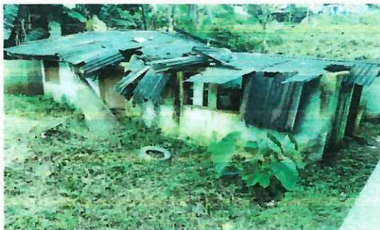
Foto 3: vista frontal de largo y ancho de la cocina que será levantada de nuevo.
