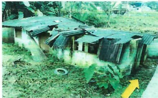
Foto 4: lado donde será colocado el drenajes entre la cocina y el modulo que está al lado derecho con desagüe en un siguan de la parte atrás del muro. (lado norte).
