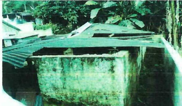
Foto 2: vista frontal de la cocina que será remodelada, mas tres hilada de block y la colocación del techado.
